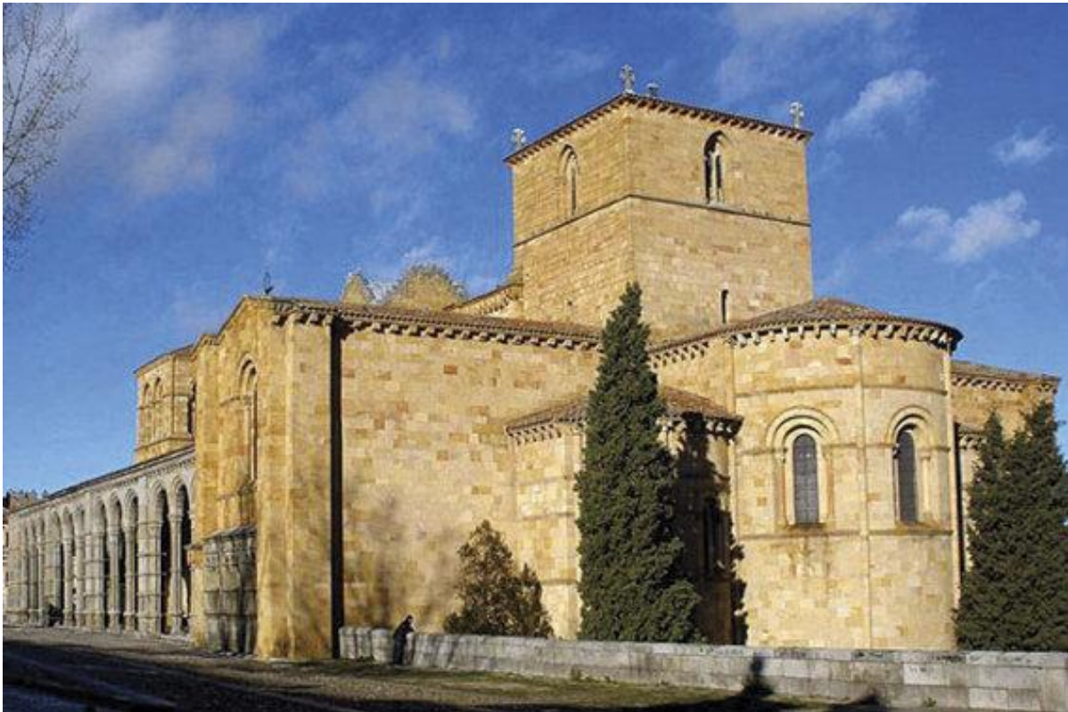
Basílica de San Vicente (Ávila), vista desde la cabecera, formada por tres ábsides. Se observa la gran nave transversal o transepto y la torre cuadrada que se eleva sobre el crucero, así como el pórtico sur a la izquierda.
