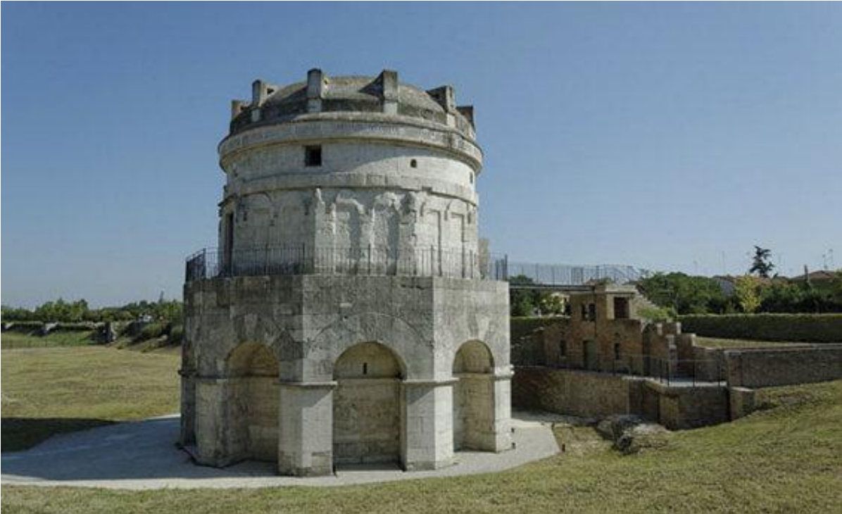
Mausoleo de Teodorico en Rávena, construcción de planta central poligonal (decágono) cubierta con falsa bóveda formada por una gran losa de mármol en la que se observan las grandes asas que sirvieron para disponerla sobre el edificio.
