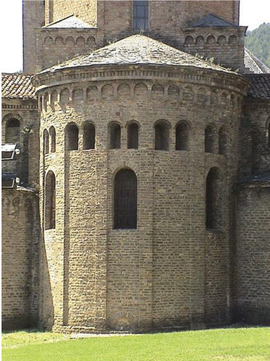
Ábside principal de la iglesia del monasterio de Santa María de Ripoll (Gerona), en el que se aprecia la típica decoración de influencia lombarda a base de bandas verticales y festones de arquillos ciegos en la parte superior.
