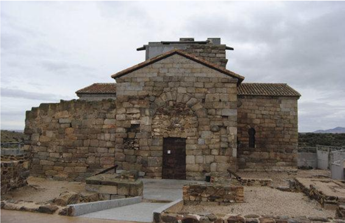
Iglesia de Santa María de Melque (Toledo), primitivo templo visigótico con añadidos mozárabes construido entre los siglos VII-IX con planta de cruz griega y sillares de gran tamaño curvados en las esquinas.
