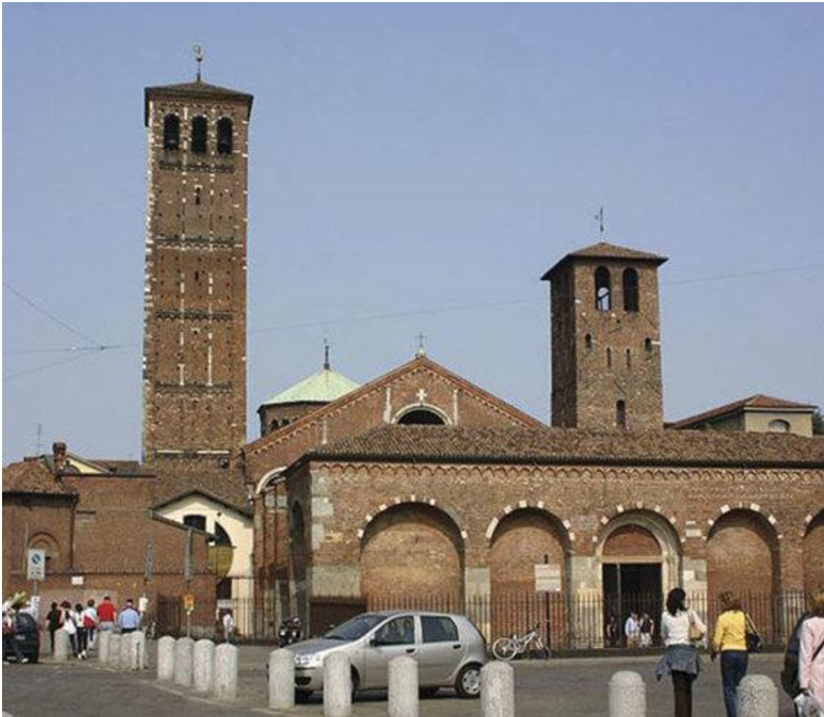
Vista de la iglesia de San Ambrosio de Milán, en la Lombardía italiana, construcción de planta basilical en sillarejo y materiales pobres, típica del primer románico, en la que destaca su elevado campanil de planta cuadrada.
