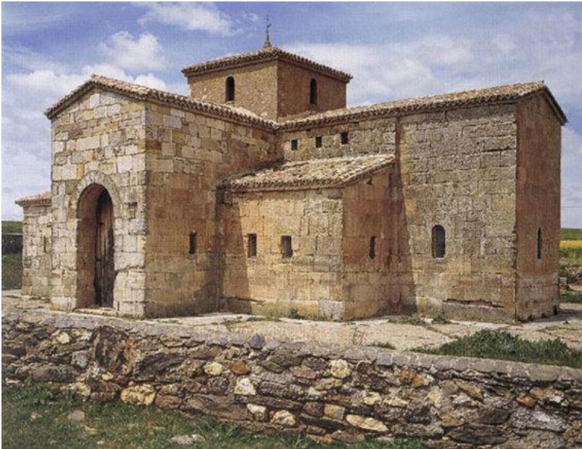
Iglesia de San Pedro de la Nave, en El Campillo (Zamora). Planta de cruz latina con transepto marcado al exterior. Obsérvense los sillares perfectamente escuadrados y el arco de herradura ligeramente peraltado en el pórtico de acceso.
