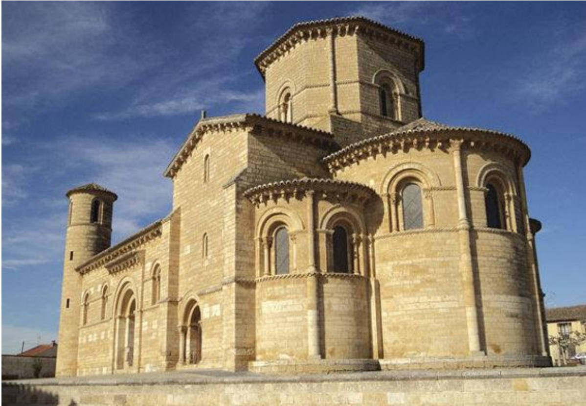
Iglesia de San Martín de Frómista (Palencia) desde el sureste. En primer término, la cabecera triple. Sobre el crucero, el cimborrio octogonal. A la izquierda, una de las dos torres cilíndricas que enmarcan la fachada occidental. Foto del autor
