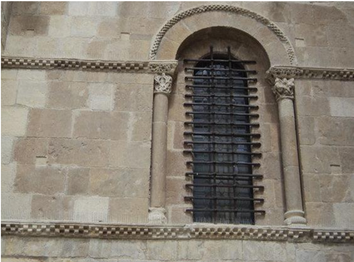
Las franjas de ajedrezado, tacos alternos entrantes y salientes imitando el tablero de ajedrez, decoran muros, portadas y ventanas románicas. Foto del autor
