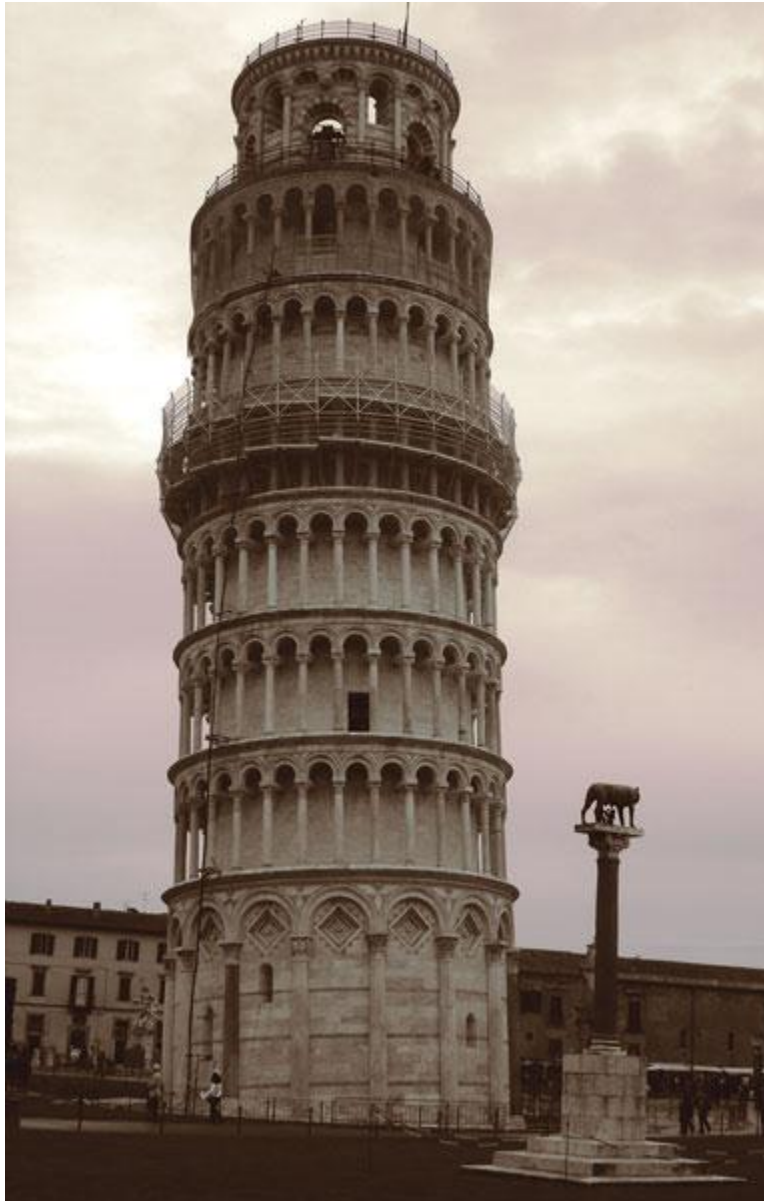
Torre Inclinada de Pisa (1073), obra de Bonnano Pisano. De planta cilíndrica, está recorrida por galerías de arcos superpuestos y revestida de mármol. Su inclinación se debe al subsuelo pantanoso y la escasa profundidad de los cimientos. Foto: Alfredo Galindo
